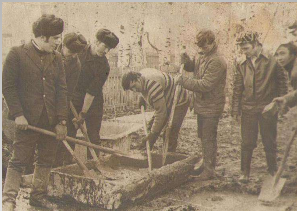
Закладка фундамента обелиска работниками РТП, с. Зура, 1975 г.
